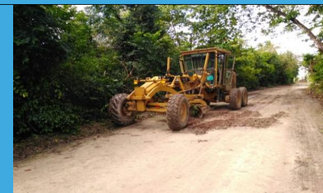
Mantenimiento Vía Elsy Bar
