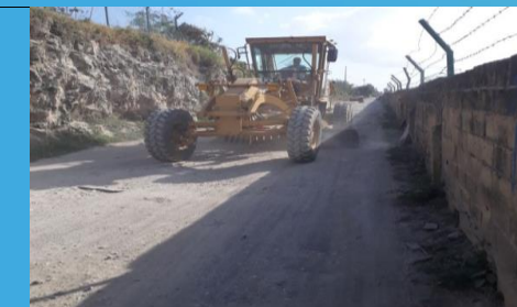
Mantenimiento Vía Crra 14
