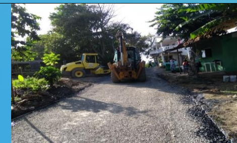
Mantenimiento via Bottom House
