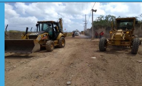
Mantenimiento Vía carrera 13
