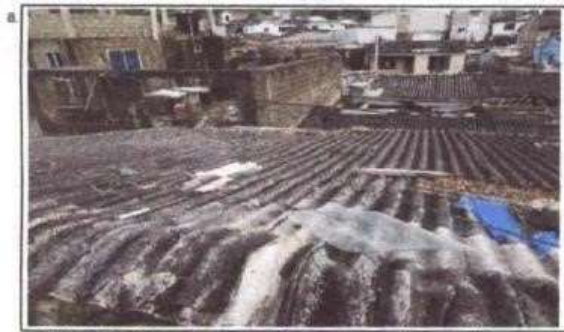
COMENTARIOS: estado inicial de la obra (cubierta)
