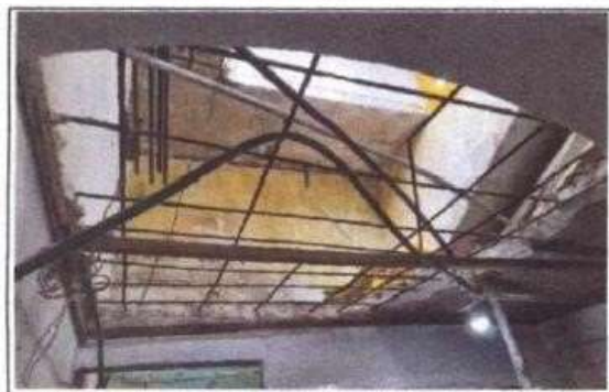
COMENTARIOS: demolición de placa de concreto y rastro de hierro existente
