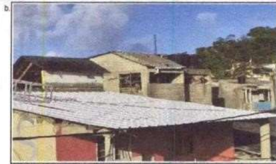
COMENTARIOS: estado actual de la cubierta nueva
