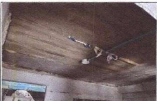
COMENTARIOS: construcción de placa entrepiso en concreto
